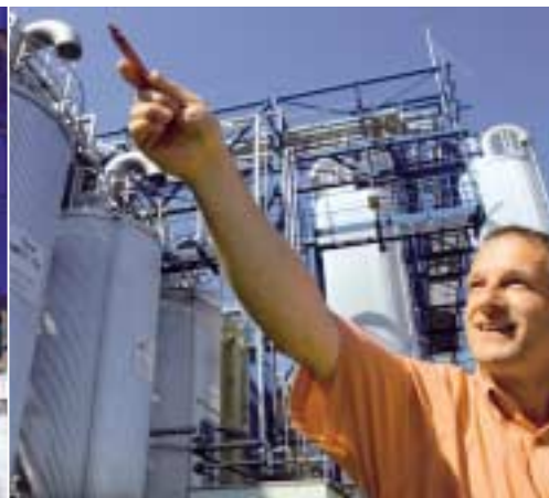
Außentanklager mit EX-gefährlichen Stoffen
